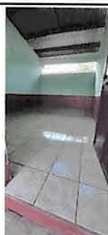
Foto 5: DIRECCION: Sustitucion de piso de cemento por piso ceramico
