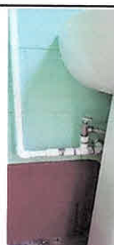
Foto 4: BAÑOS: Instalacion de tuberia de agua potable.
