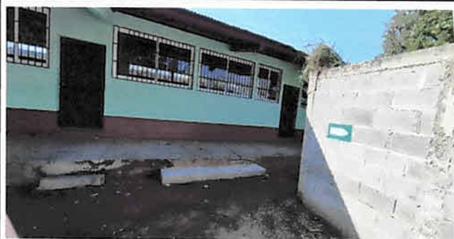
Foto1: AULAS Sustitucion y fabricacion de ventaneria de PVC en Aulas
