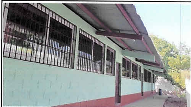
Foto 2: AULAS Pintura general paredes
